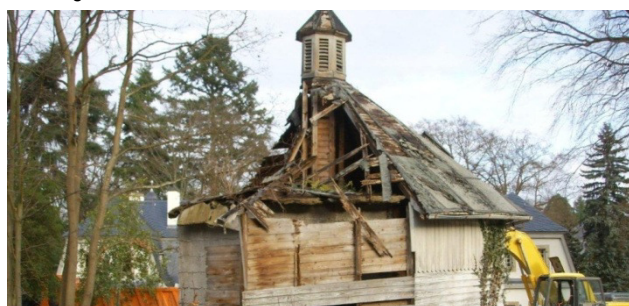
Kühlhaus im Jahr 2007, konnte nicht erhalten werden
