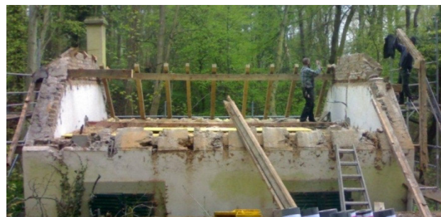
Pumpenhaus auf halber Höhe wird wiederaufgebaut
